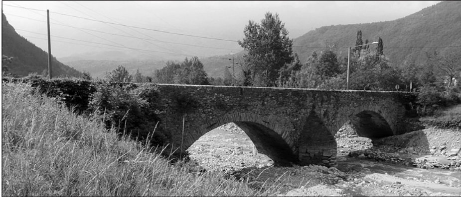
Il ponte sul Cenischia.
